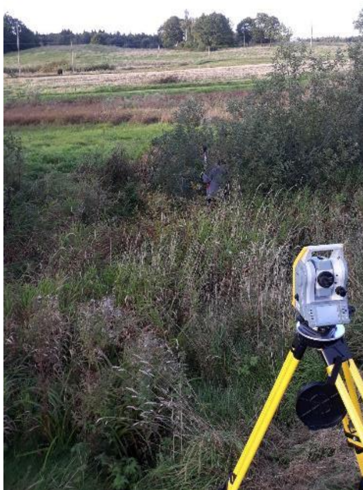
15 pav. Upelio vagos ir slėnio niveliavimo darbai
